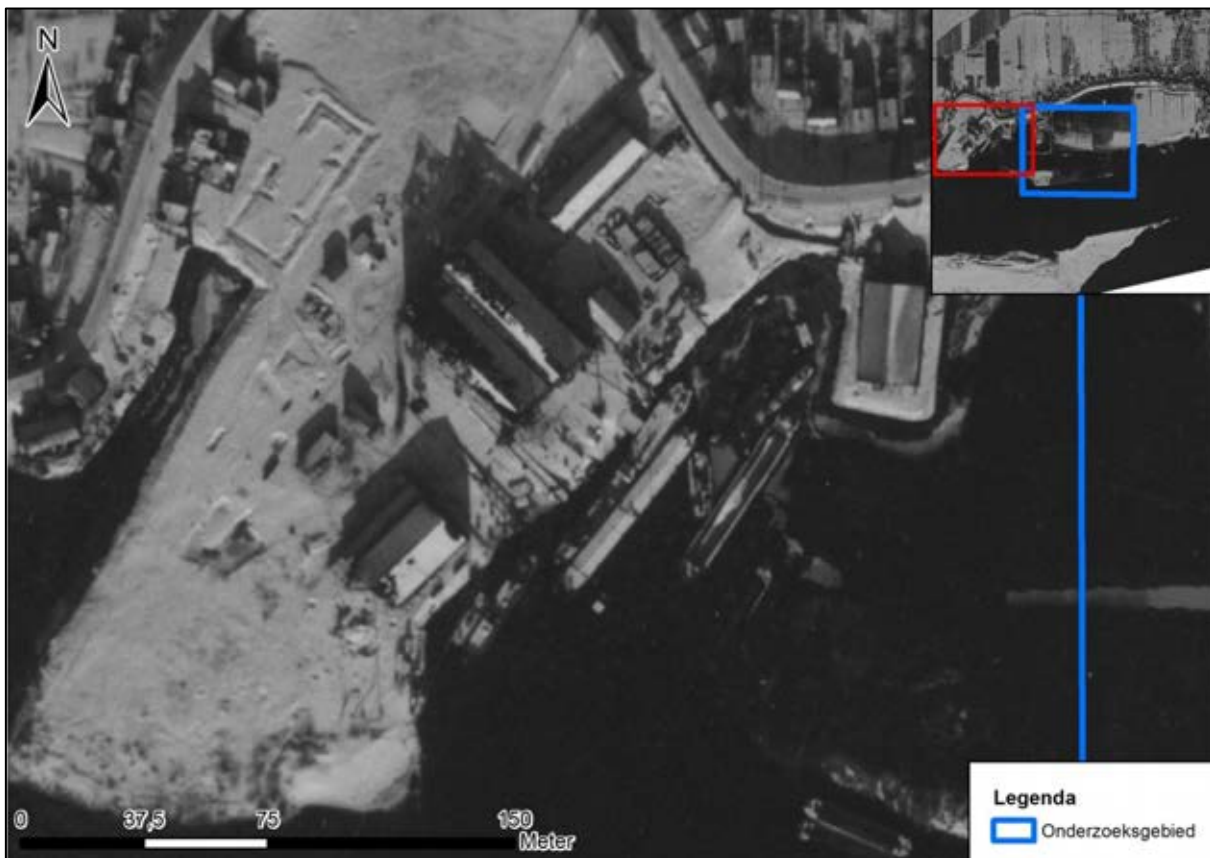
Figuur 16. Scheepswerf "De Holland" op de luchtfoto van 22 januari 1945 (Bron: Luchtfoto 4/1649-3072)
