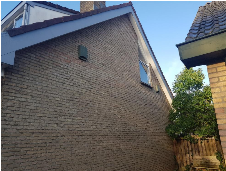
Zijgevel: Buitendams 51 (naast te slopen villa)
