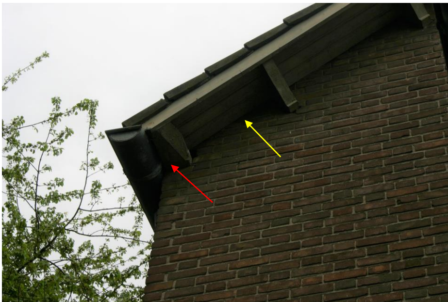
Figuur 4.4.1. Opening geschikt voor gierzwaluwnest (rode pijl) en kieren waar vleermuizen door naar binnen kunnen (gele pijl) in het kerkgebouw.
