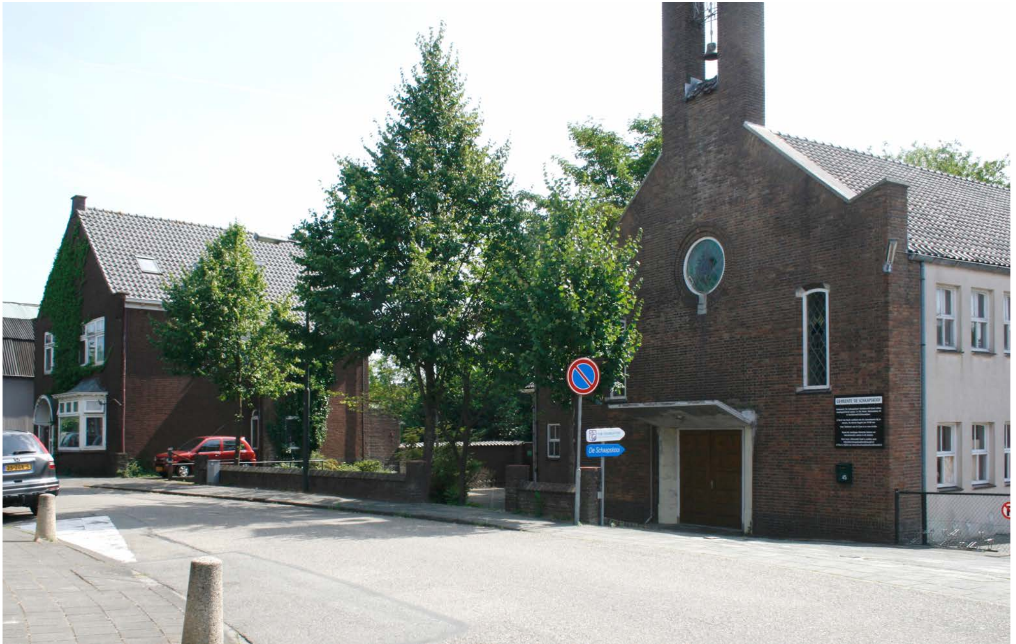
Foto voormalige bebouwing plangebied gezien vanaf Buitendams.
