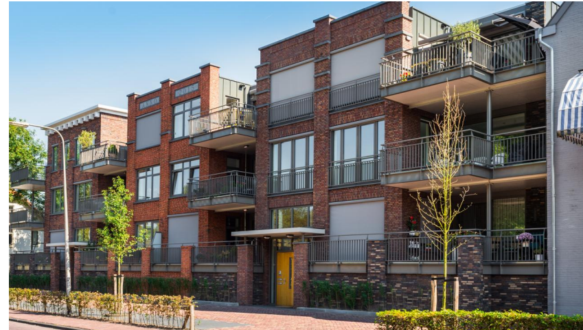
referentie pandsgewijze schakering bebouwing, onderbreking van doorgaand volume door terugsprong bij de balkons
