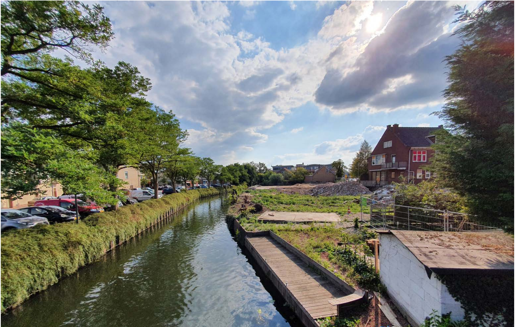
Foto huidige bebouwing plangebied vanaf de Buiten Giessen
