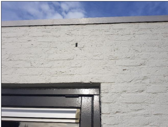
Figuur 13. Open stootvoeg aan zuidzijde woning
