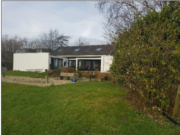
Figuur 5. Achterzijde woning perceel 1
