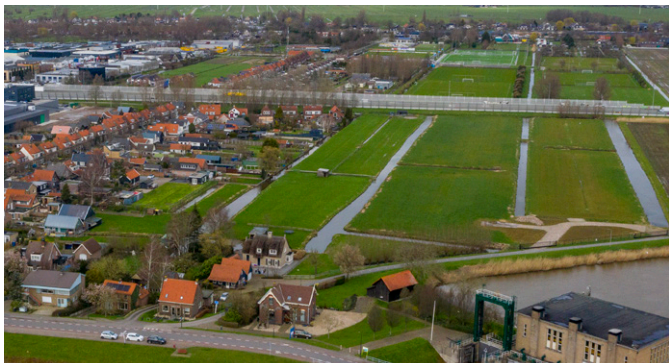
Dorpsrand als 'achterkant' van Hardinxveld-Giessendam, en op voorgrond deel van het gemaal ensemble
