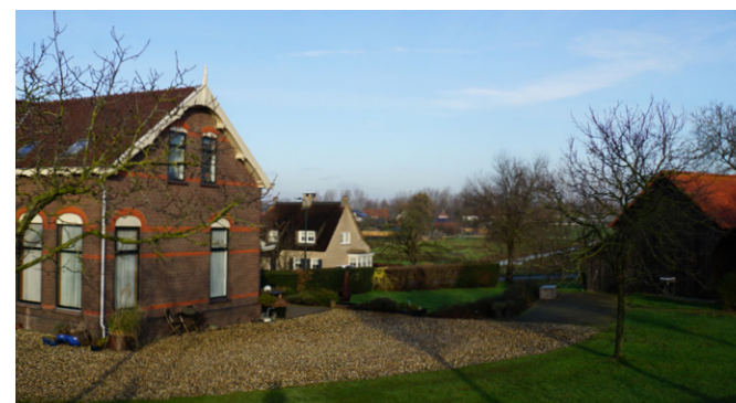
Het groene erf van de sluiswachterwoning en doorkijk naar open achterland
