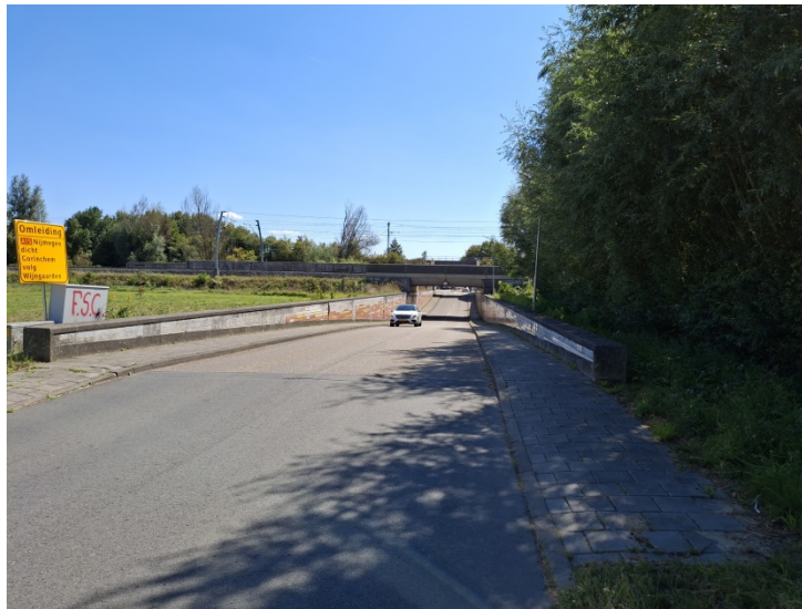
Tunnel onder spoor in Sliedrecht
